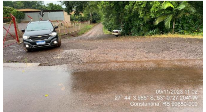
Vista final do trecho RS 500
