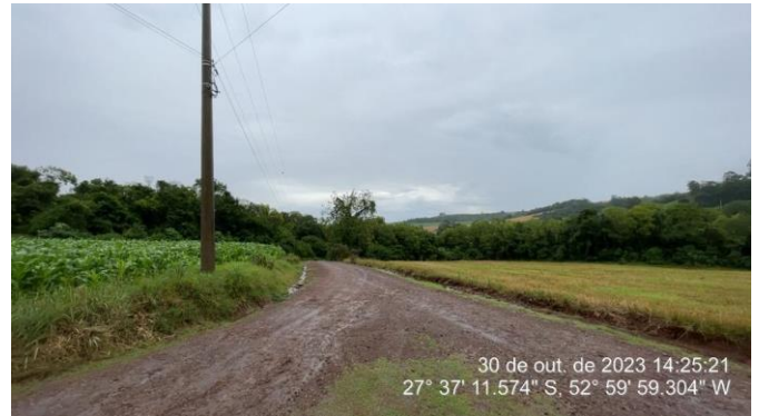
Vista Trecho próximo ao final Lado da Igreja
