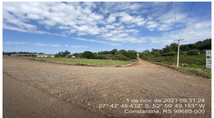
Vista início do trecho
