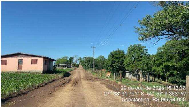
Vista do trecho Comunidade de Alto Paraíso
